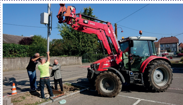
Déplacement poteau lumineux
