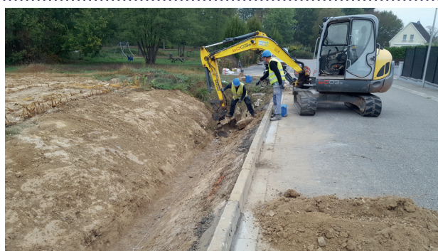
Aire de jeux : Aménagement du fossé
